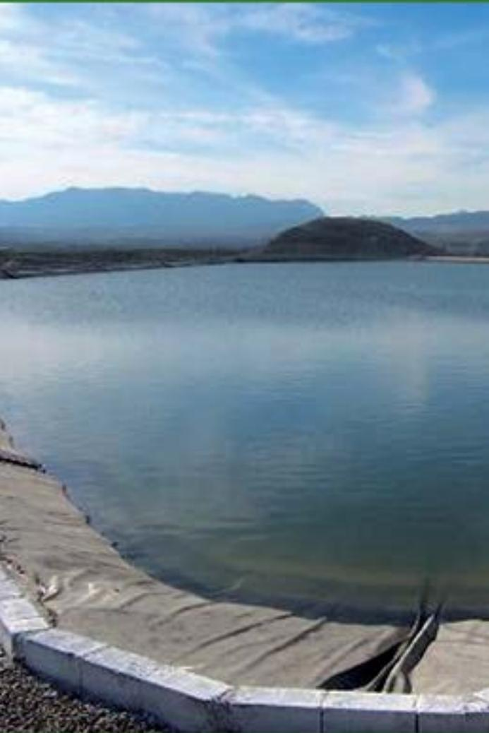
La géomembrane de **DIMATIT** est un film homogène obtenu par extrusion gonflage en tri couche. Le polyéthylène matière de base est par excellence résistant aux agressions chimiques liquides ou solides et procure au film une souplesse et donc facilité de mise en oeuvre pour des formes complexes ou de petites surfaces.
